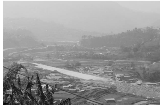
写真2 ブンガマティ村近くの 幹線道路建設の様子 (筆者撮影 2019年8月)
